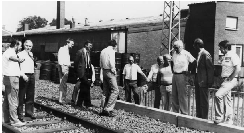
Vertreter der Stadtverwaltung, Bundesbahn und Baufirma nehmen die Baustelle ab.
